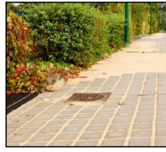
Pavé bétons avec joints sablés
