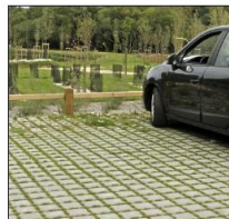
Pavé bétons avec joints engazonnés
