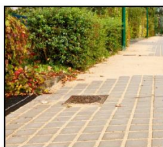
Pavé bétons avec joints sablés
