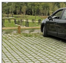
Pavé bétons avec joints engazonnés
