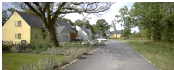
Voie mixte en revêtement perméable
