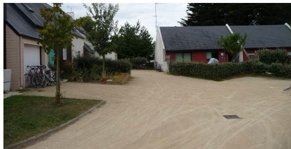
Desserte d'un lotissement composée de matériau perméable.
