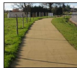
Sablé stabilisé renforcé
