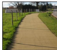
Sablé stabilisé renforcé
