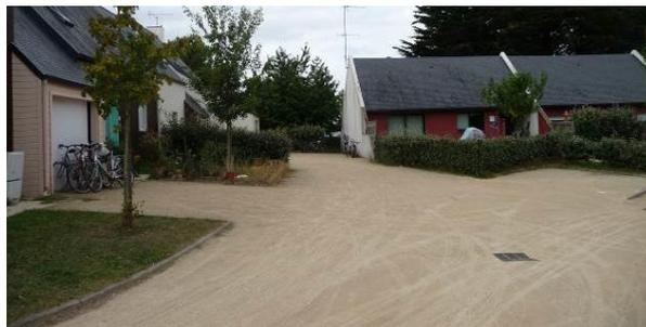
*Desserte d'un lotissement composée de matériau perméable.*
