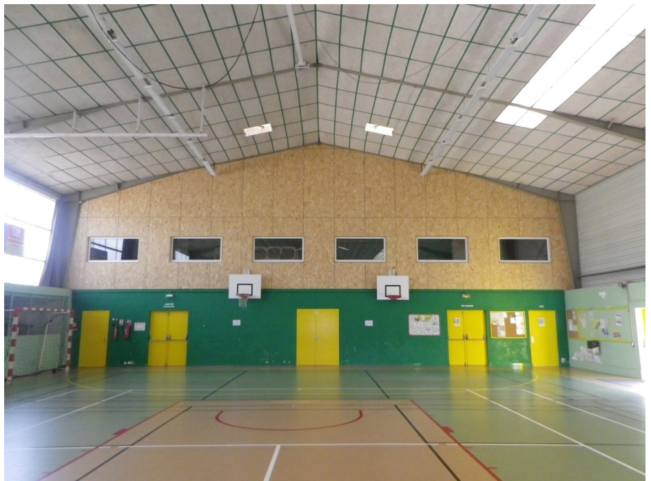
Aperçu de la Salle isolée côté mezzanine
