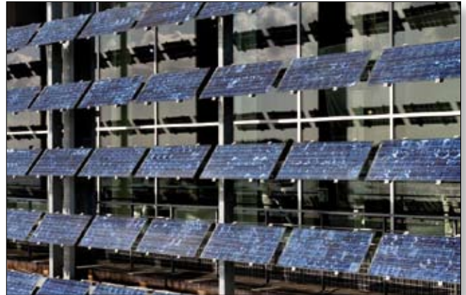
Panneaux photovoltaïques utilisés en pare-soleil © Laurent Mignaux – MEDDE.
