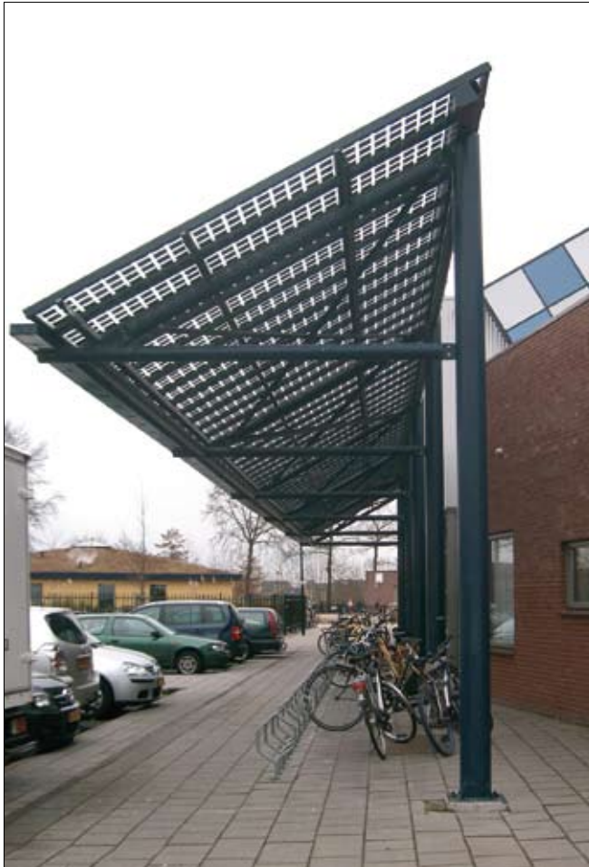
Panneaux photovoltaïques pour protéger un parking à vélos © Hespul/X.
