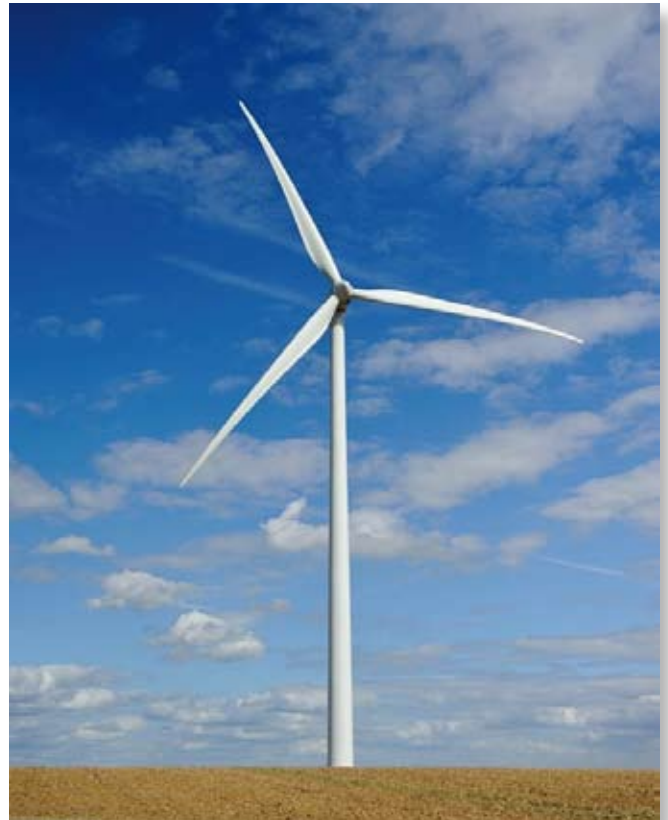
Aérogénérateur de type « grand éolien » d'une puissance de 2 MW. © Arnaud Bouissou – MEDDE.
