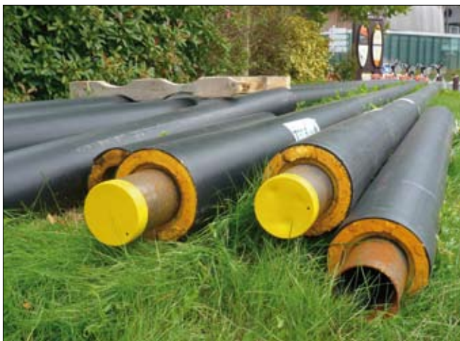
Mise en place d'un réseau de chaleur © Cete de l'Ouest - PCI Réseaux de chaleur
